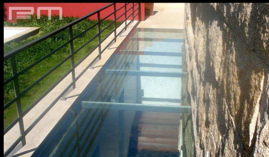
Estrutura metálica e Vidro . Metallic and Glass structure
